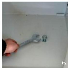
Anschließend wird die Schraube in den Dübel geschraubt und mit einer Mutter festgezogen.
