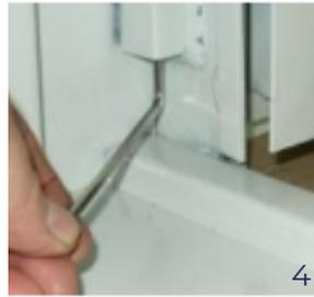
Drehen Sie die Einstellschraube im Uhrzeigersinn.
