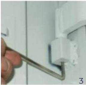
Mit dem Sechskantschlüssel stecken Sie in die Schraube des Scharniers ein.
