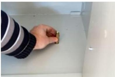
Anschließend wird der Dübel in das Loch eingeführt.
