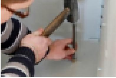
Mit einem Hammer wird der Dübel in der Wand befestigt.
