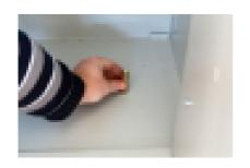
Anschließend wird der Dübel in das Loche eingeführt.
