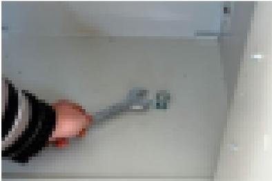
Anschließend wird die Schraube in den Dübel geschraubt und mit einer Mutter festgezogen.
